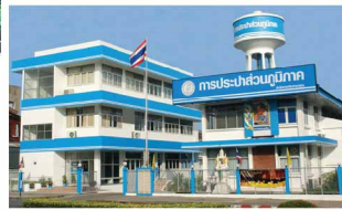
การประปาส่วนภูมิภาค Provincial Waterworks Authority
