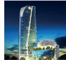
สำนักงานการไฟฟ้านครหลวง Metropolitan Electricity Authority
