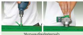
ใช้เจาะและเชื่อมข้อต่ออานม้า
