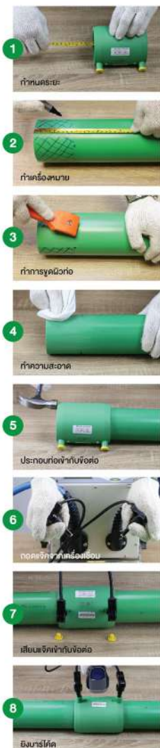
*ห้ามใช้ข้อต่อ Bushing ที่นการต่อโรงแบบ E.F.
